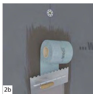
Uden wedi 610 forsynes alle byggepladesamlinger med fliseklæber, og wedi Tools tætningsbånd påføres.
